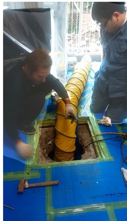
塩ビ管とのことであったが、掘り出したところ鉄管だった。腐食がひどい
