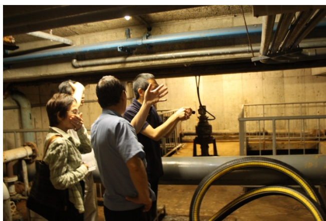
防火水槽内部見学
