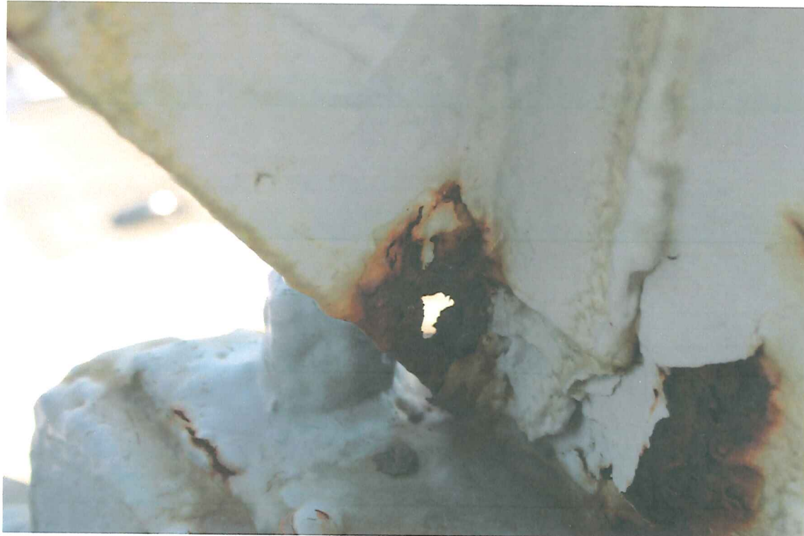
3、高架タンク架台の支柱
