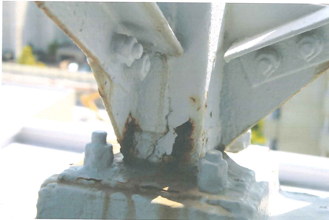
4、高架タンク架台の支柱
