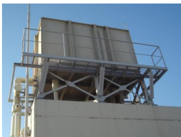
↑屋上・高架水槽
