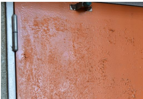
A棟 住戸玄関扉
