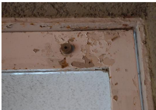
A棟 出入口扉
